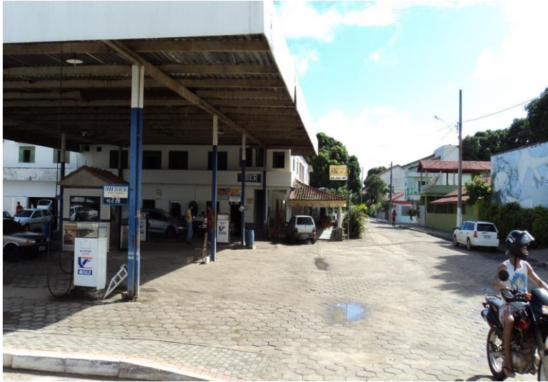
Pista de abastecimento
