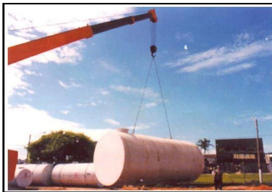
Figura 1: Instalação de tanques subterrâneos.
