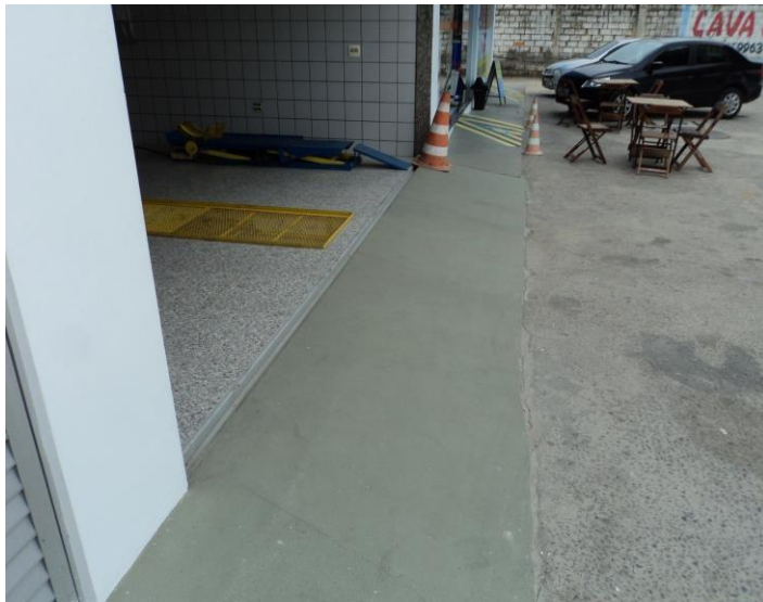
Fosso – Canaleta frontal
