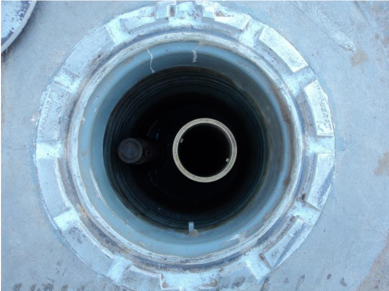
Área de descarga - Boca da descarga
