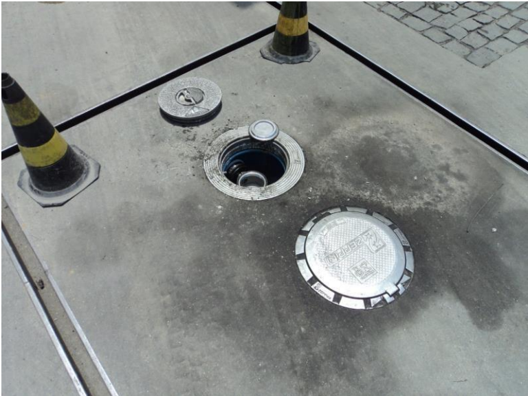
Área de descarga - Tampa da boca de visita do monitoramento intersticial aberta
