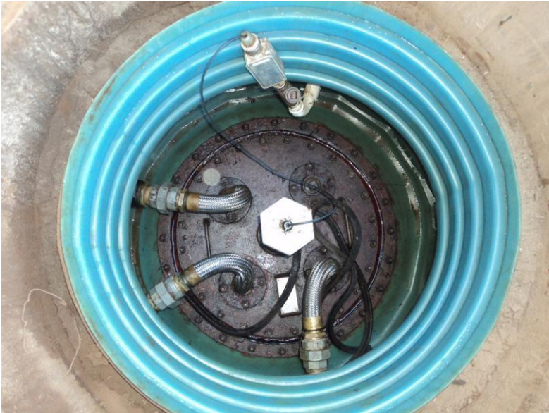
Boca do tanque com plaqueta de identificação e sensor medidor de volume
