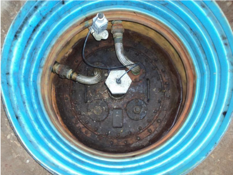
Boca do tanque - Ausência de plaqueta de
