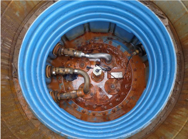
Boca do tanque com plaqueta de identificação e sensor medidor de volume
