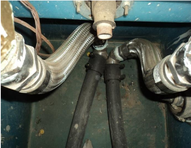
Area de abastecimento – Câmara da unidade
