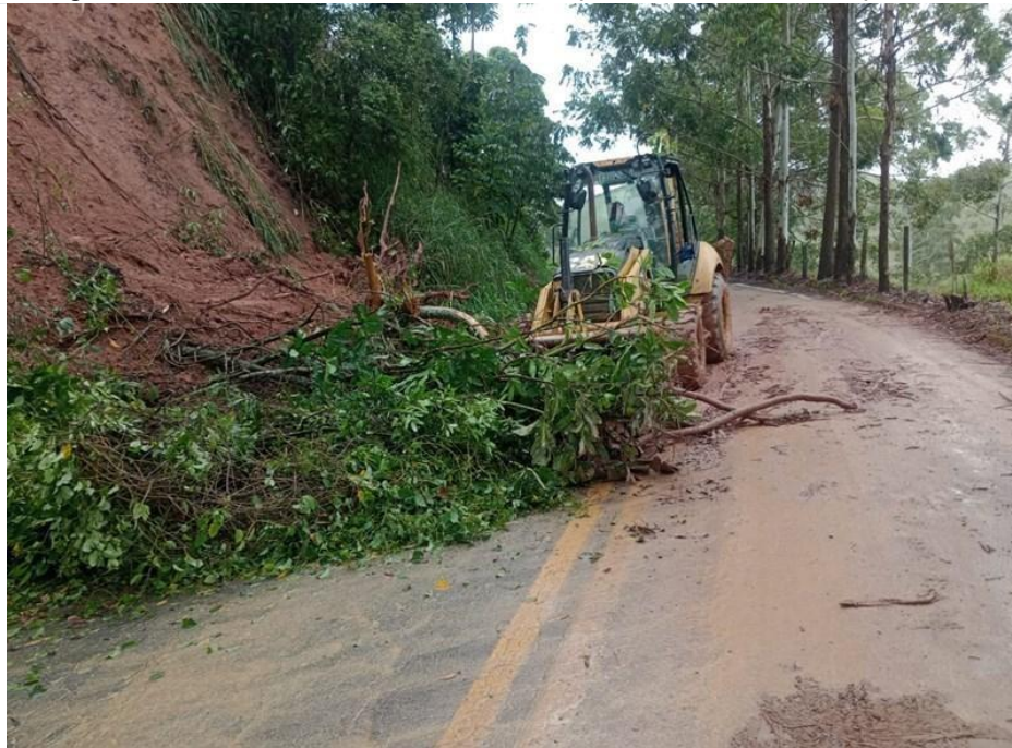
Figura 13 – Rodovia - ES 080 - Santa Leopoldina é interditada após deslizamento
