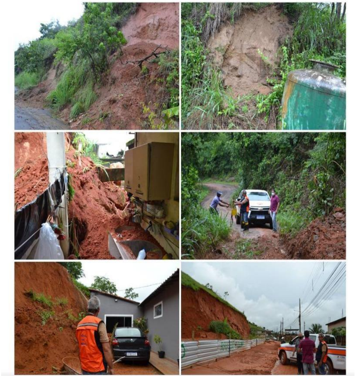
Figura 16 – Deslizamentos de terra devido a fortes chuvas em Santa Leopoldina
