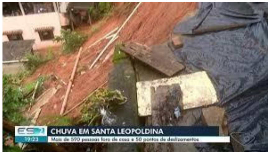
Figura 1 – Pontos de deslizamentos na Rodovia ES-080
