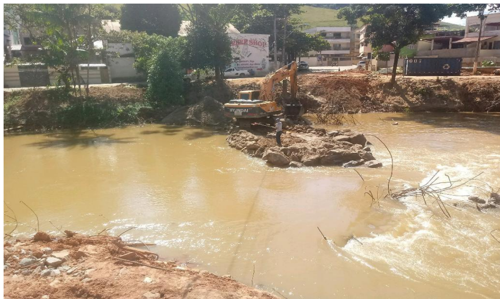
Figura 05 – Maquinários na retirada do pilar central da ponte março/2020 – Ponte Sagrada Família
