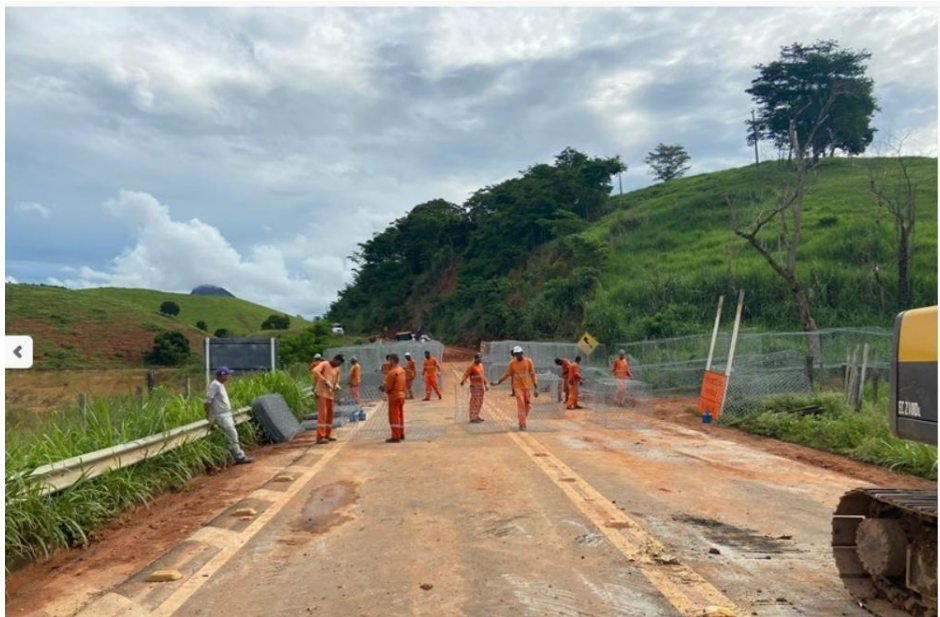
Figura 08 – Trecho que vai da BR-101 a Mimoso do Sul, obras de restauração da rodovia interditada
