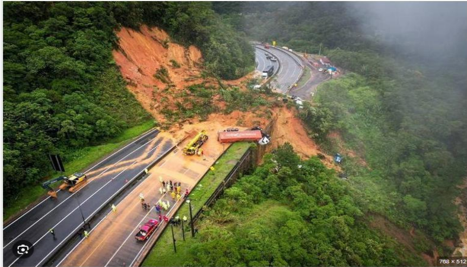
Figura 17 – Chuvas causam deslizamentos
