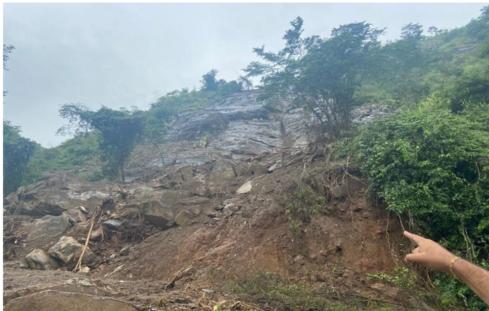
Figura 04 – Rodovia ES-391 – Trecho que vai da BR-101 a Mimoso do Sul
