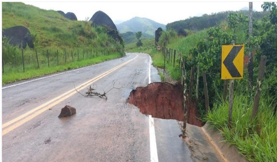
Figura 09 – Trecho que vai da BR-101 a Mimoso do Sul, obras de restauração da rodovia interditada
