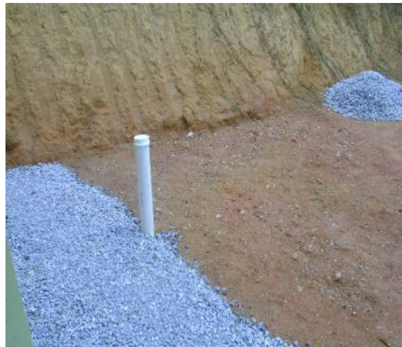
Poço piezométrico “errado”
