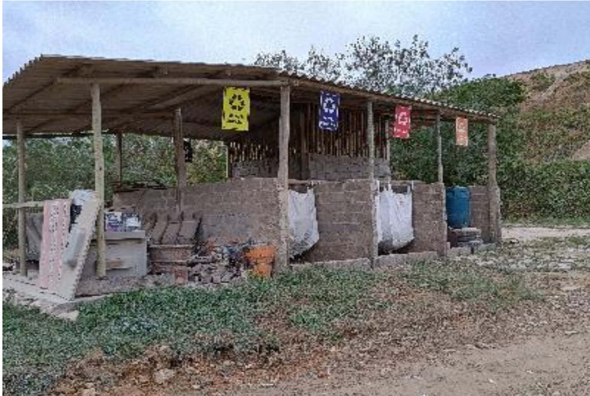
Estrutura para armazenamento de resíduos
