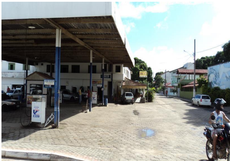
Pista de abastecimento inadequada
