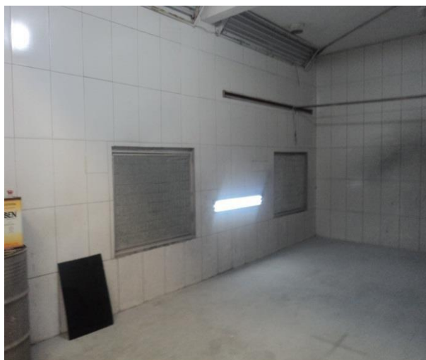
Interior da Cabine - Vista interna da cabine de pintura, contendo os sistemas de filtragem de parte dos efluentes atmosféricos
