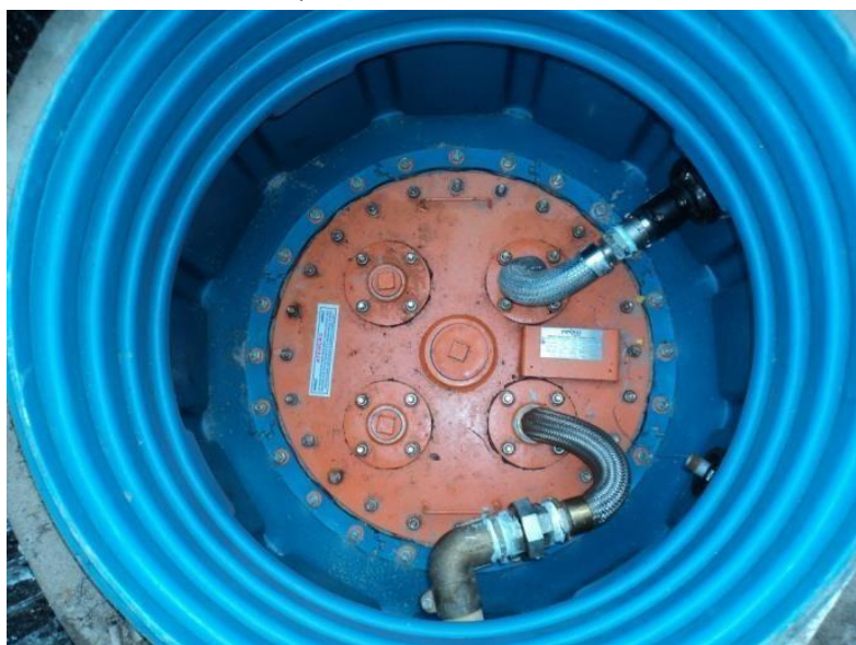
Boca de visita do tanque – Ausência do sensor medidor de volume
