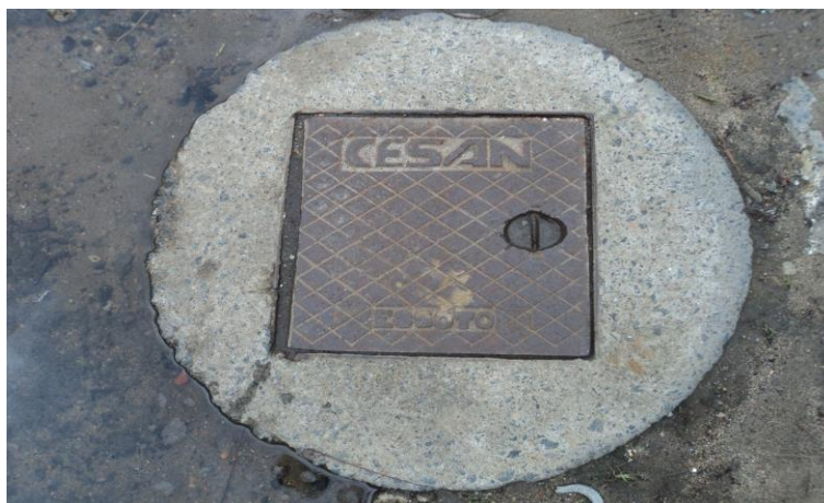
Acesso a rede de esgoto
