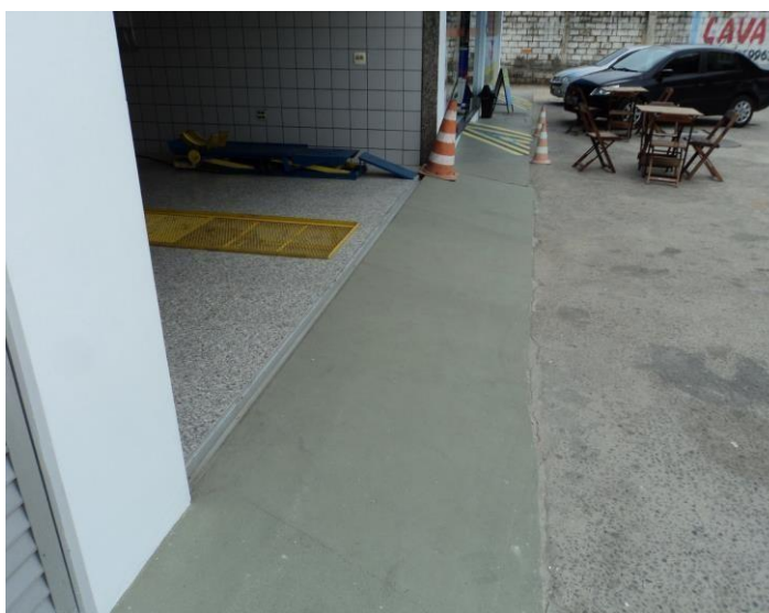
Fosso – Canaleta frontal instalada
