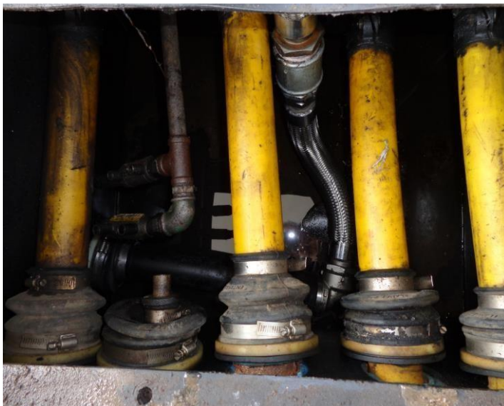
Área de abastecimento – Câmara de contenção do filtro diesel
