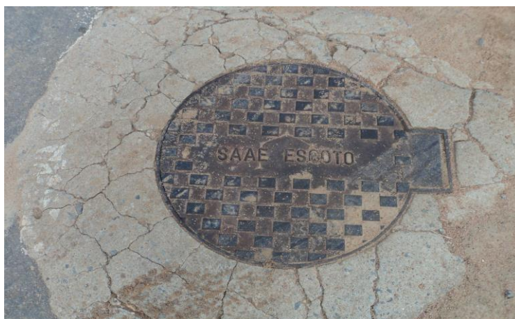
Acesso a rede de esgoto
