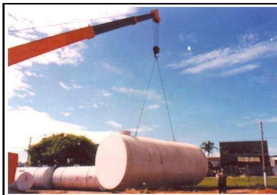
Figura 1: Instalação de tanques subterrâneos. Fonte: tecnoposto.
