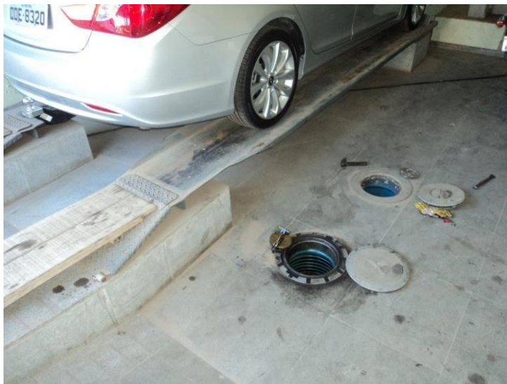
Tanque de óleo usado – Local de acesso para instalação do cabeamento do sensor do sistema eletrônico de monitoramento intersticial
