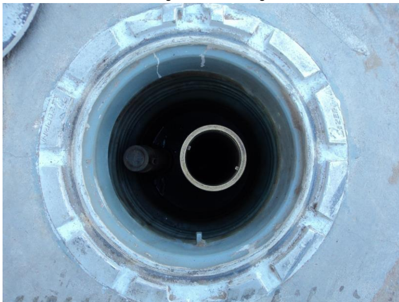
Área de descarga - Boca da descarga selada
