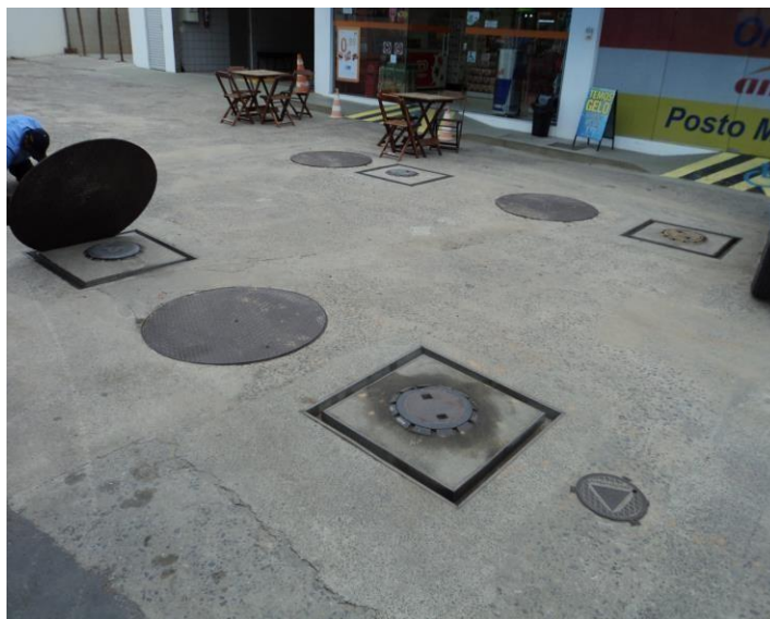
Área de descarga
