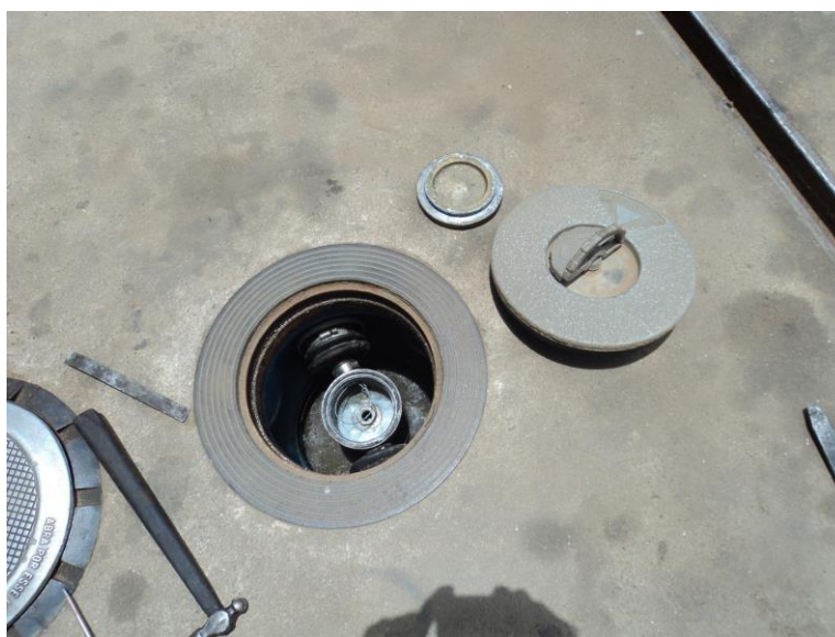
Área de descarga – Arame de espera do cabeamento do sistema de monitoramento eletrônico intersticial
