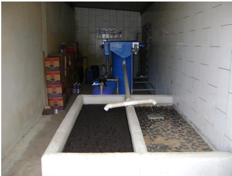
Leito de secagem da estação de tratamento físico-químico
