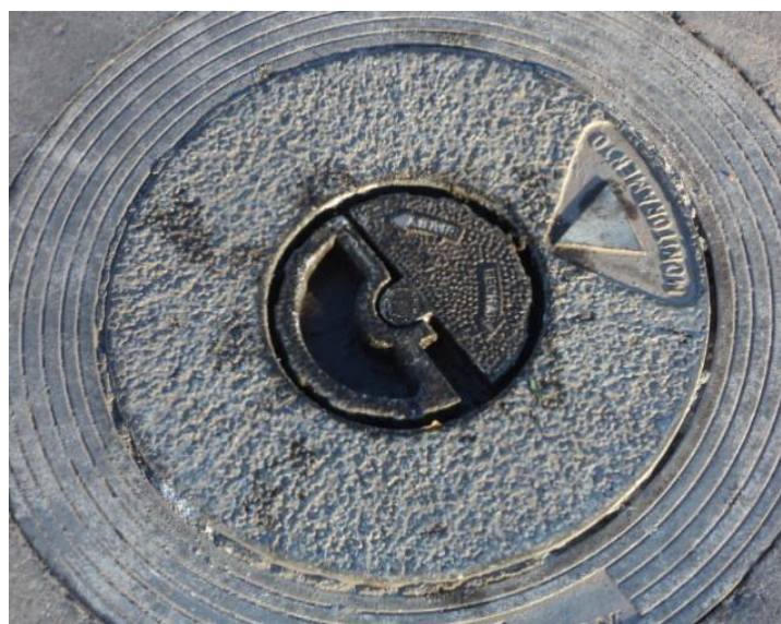
Área de descarga - Tampa da boca de visita do monitoramento intersticial
