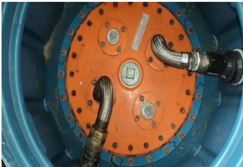
Boca do tanque - Ausência de plaqueta de identificação e sensor medidor de volume
