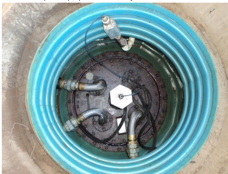
Boca do tanque com plaqueta de identificação e sensor medidor de volume
