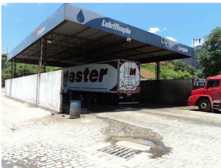
Estação de tratamento físico-químico do efluente do lavador
