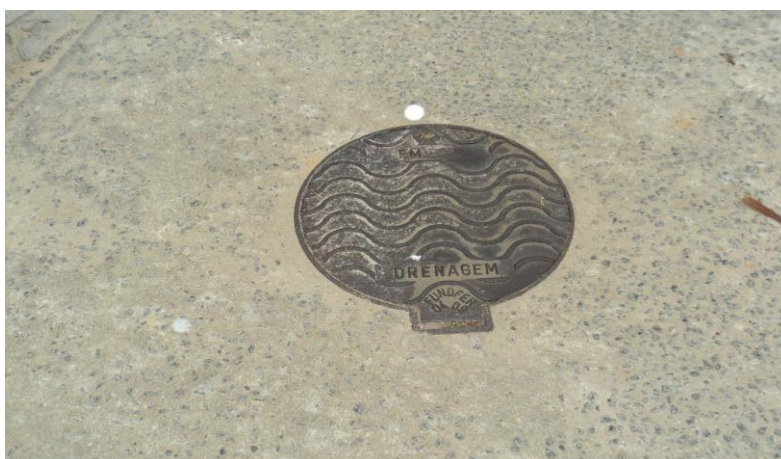
Acesso a rede pluvial
