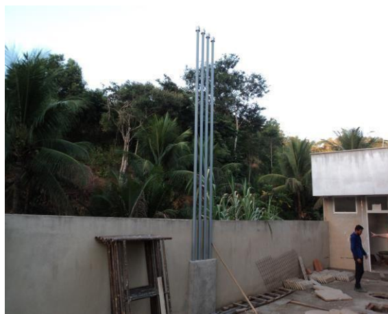
Respiros de tanques – local de instalação de válvula de esfera
