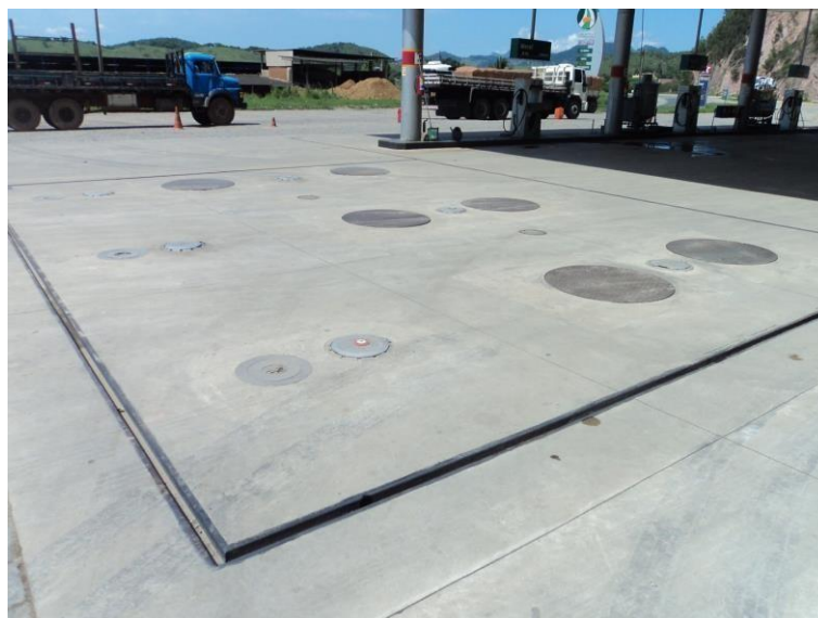
Área de descarga de combustíveis
