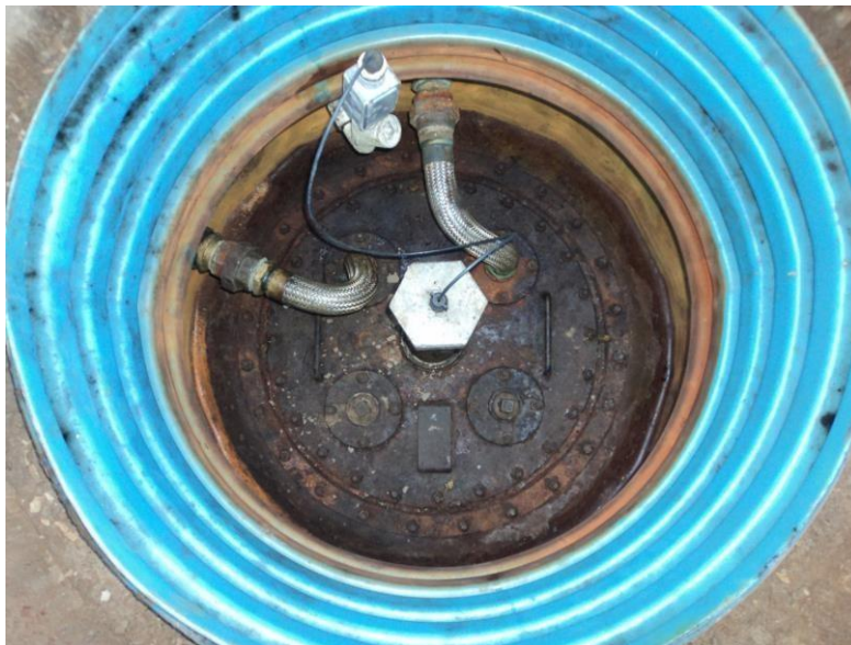
Boca do tanque - Ausência de plaqueta de identificação
